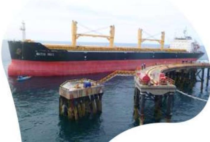
**Se instalaron y ensayaron seis líneas de fondeo, con pruebas de tracción de hasta 150 toneladas.**
